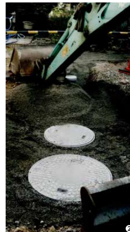
①庭に軽自動車1台分程度の穴を掘り、合併処理浄化槽（5人槽）を設置②浄化槽を埋めた後、③の写真のようにコンクリート工事を施してきれいに整備します④浄化槽の内部では「ろ材」や「微生物」が汚水を分解し、きれいな水に変えます⑤くみ取りトイレを撤去し、新たに水洗トイレを設置。Tさんは「市役所や業者さん、そしてトイレの神様に感謝です」と笑顔で話しました
