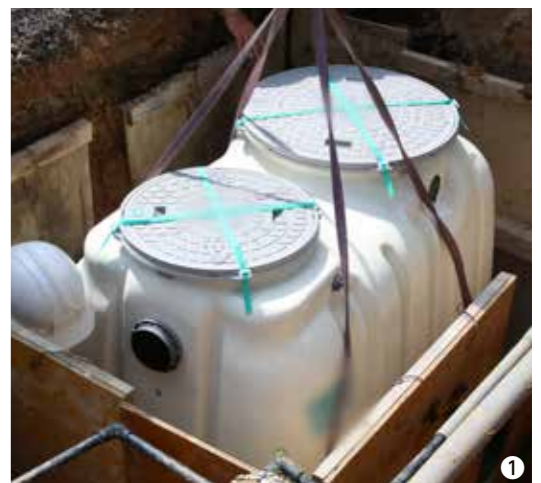
①庭に軽自動車1台分程度の穴を掘り、合併処理浄化槽（5人槽）を設置②浄化槽を埋めた後、③の写真のようにコンクリート工事を施してきれいに整備します④浄化槽の内部では「ろ材」や「微生物」が汚水を分解し、きれいな水に変えます⑤くみ取りトイレを撤去し、新たに水洗トイレを設置。Tさんは「市役所や業者さん、そしてトイレの神様に感謝です」と笑顔で話しました
