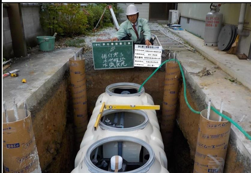
○浄化槽設備士が水張りし、水平を確認していること。（縦・横方向）
